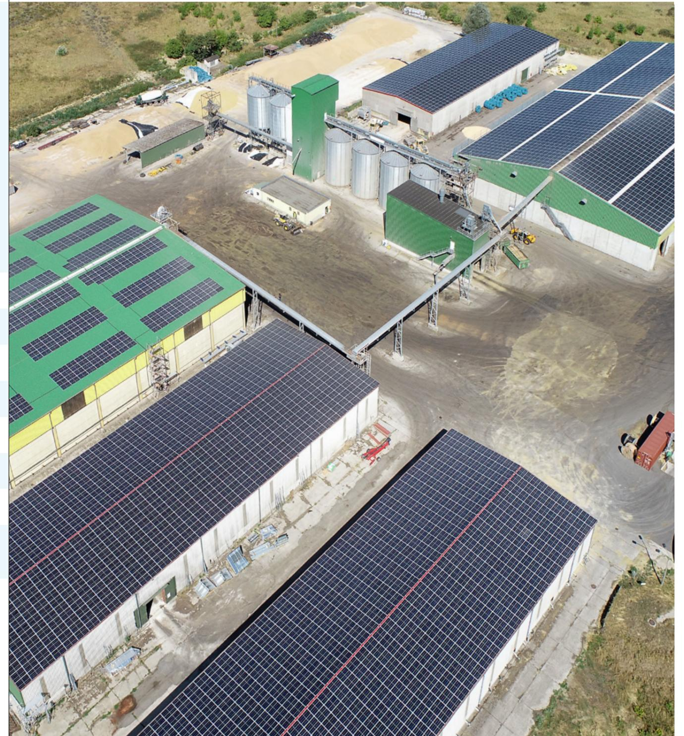
Im Zuge der Installation wurden 5.400 qm asbesthaltige Dächer saniert
